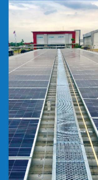
**“โซลาร์รูฟท็อป”** การนำพลังงานแสงอาทิตย์มาผลิตเป็นกระแสไฟฟ้า หรือที่เรียกว่า “เซลล์แสงอาทิตย์” เพื่อทดแทนการผลิตไฟฟ้าในรูปแบบเดิม ติดตั้งบนอาคารโรงงาน เพื่อให้อาคารที่ติดตั้งได้ทำการผลิตไฟฟ้าไว้ใช้เอง ในเวลากลางวัน เป็นการประหยัดไฟฟ้าและลดภาวะโลกร้อน
